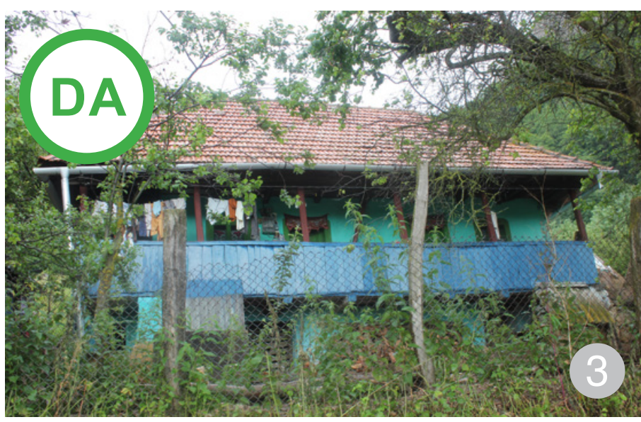
AȘA DA: Acoperiș în patru ape cu țiglă.
