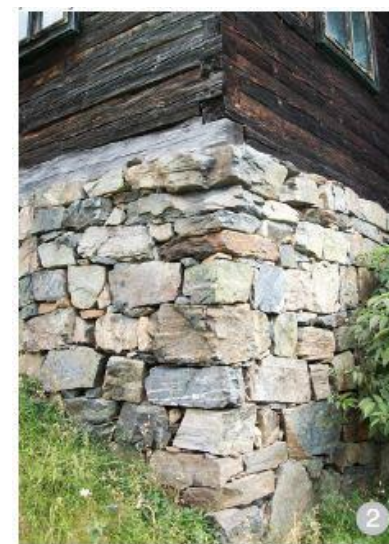
Fundațiile sunt realizate din piatră
