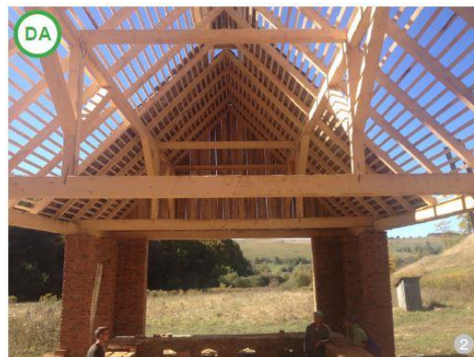
ASA DA: Șarpanta realizată cu „scaun”, specifică construcțiilor cu deschidere mare.
