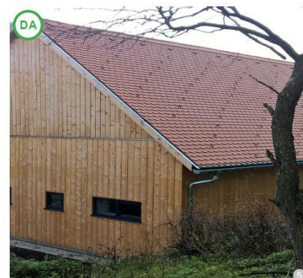
ASA DA: Pentru construcții noi, se pot folosi țigle industriale care respectă forma și dispunerea tradițională.
