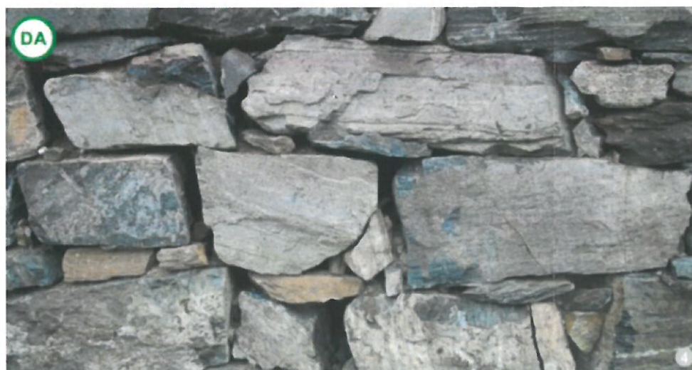
ASA DA: Exemplul prezintă o structură de piatră portantă netencuită (imagine zona Băișoara).
